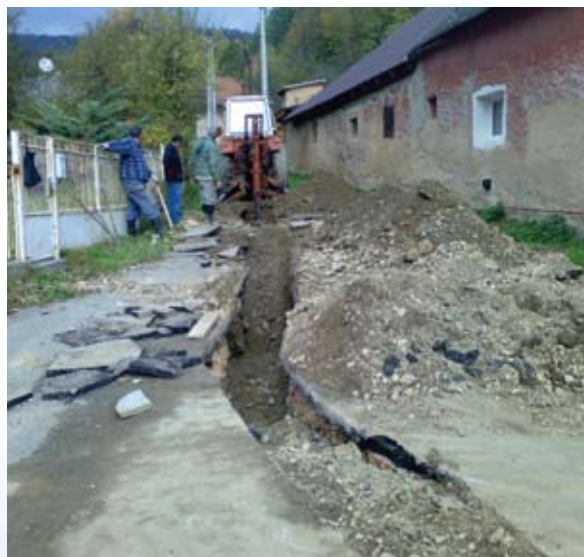
Výkopové práce pre kanalizáciu v Grunde
