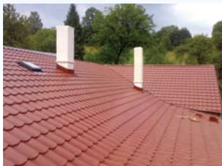
Nová strecha, ktorej výstavbu a financie zabezpečovala obec
