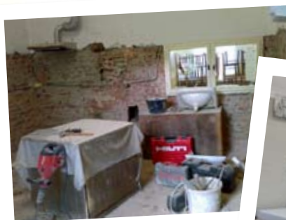
Rekonštrukcia kuchyne ZŠ
