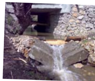
Opravený most s novou kaskádou
