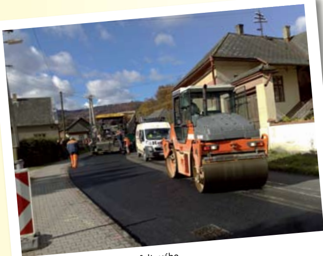
Práce pri kladení nového asfaltového koberca v spodnej časti obce
