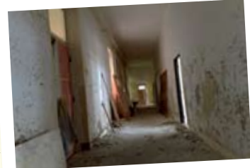
Chodba v ZŠ pri oprave
