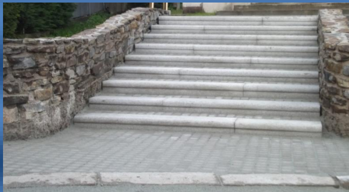
Rekonštrukcia schodov a nový stromček umiestnený v parku
