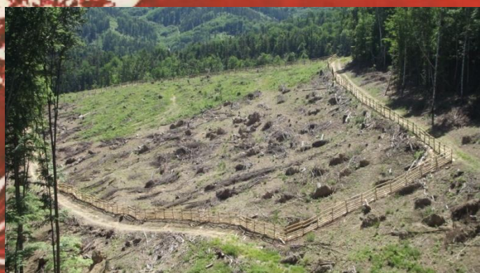
Výstavba dreveného oplotenia
